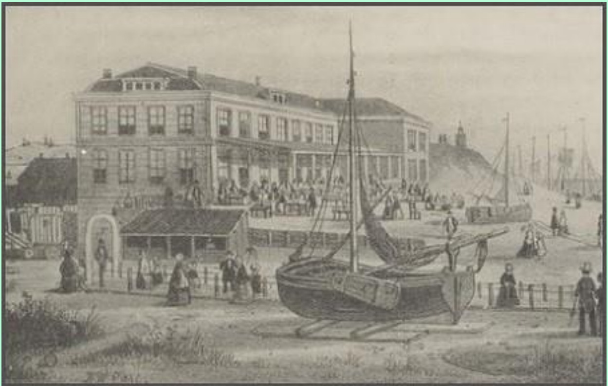
Hotel Zeerust te Scheveningen (1855). Zo moeten Karel en zijn vrouw het hotel vanaf 1877 hebben gehuurd. Na hen is, na een grondige verbouwing in 1882, de buitengevel geheel veranderd.
